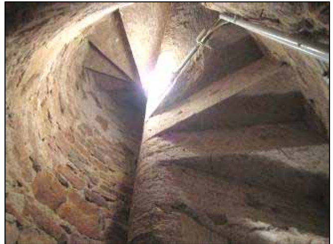
Wendeltreppe in das Glockengeschoss
