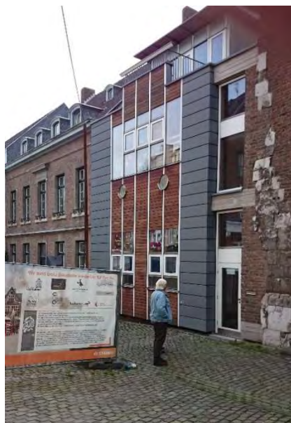
Baulückenschluss in Aachen
