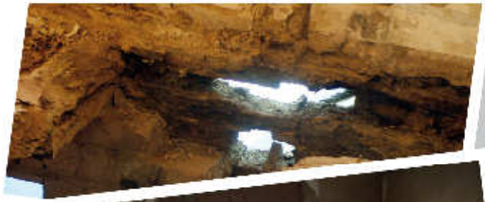
Detail Außenwand Bereich ehem. Nasszellen 1. OG
