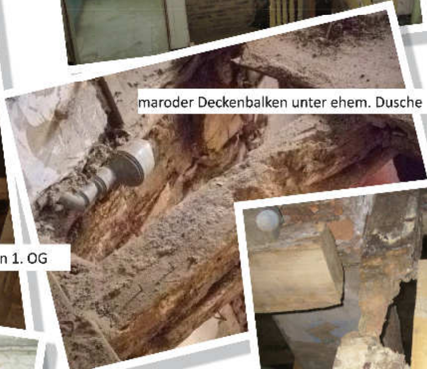
komplett abgefauter Deckenbalken
