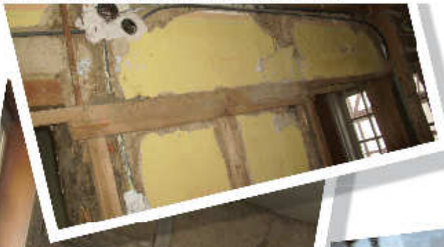
vor Baubeginn 2015, alte Unterkonstruktion für ehem. Holzvertäfelung, Ekt. Installation 1
