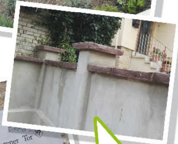
Rekonstruktion der historischen Mauer am Pumpengässchen
