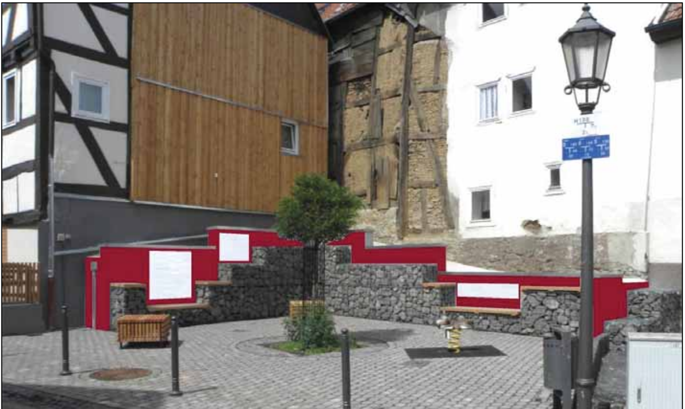
Vorschlag des Altstadttreffens zur farbigen Gestaltung der Betonmauer (Farbe siehe Seite 5) mit Informationstafeln
